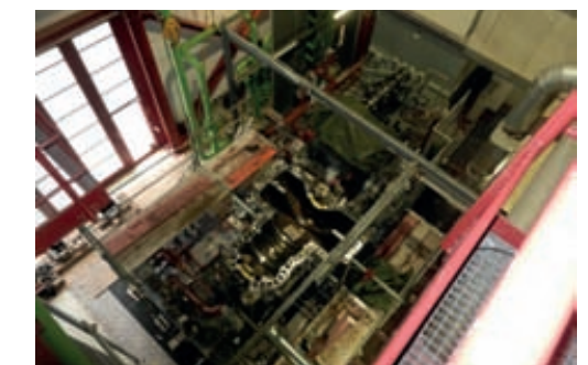
Gehäuseunterteil nach Demontage des Turbinenläufers
